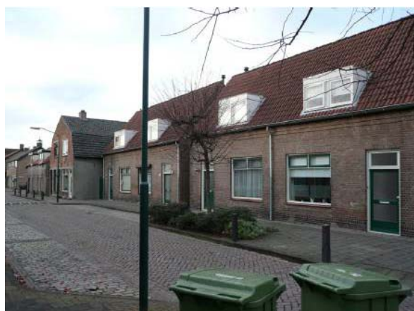
Bestaande gevels Lage Wipstraat
