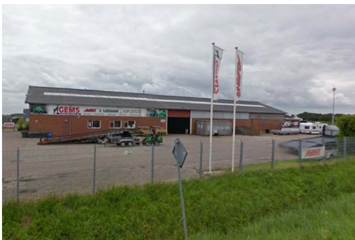
Bedrijfsgebouw Gems, gelegen ter hoogte van het plangebied aan de oostzijde van het Steenpad Gemeente Moerdijk
