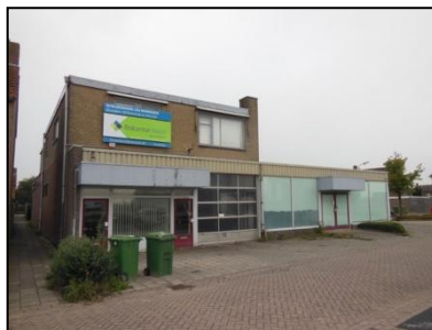
Figuur 4. Zuidzijde bebouwing.
