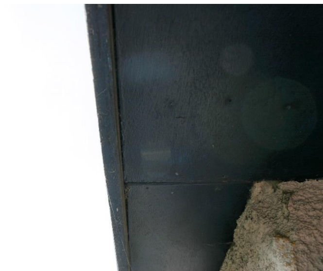
Figuur 4.4.2. De gootbetimmering sluit overal nauw aan; er is hierdoor geen ruimte waar vleermuizen in kunnen vliegen.
