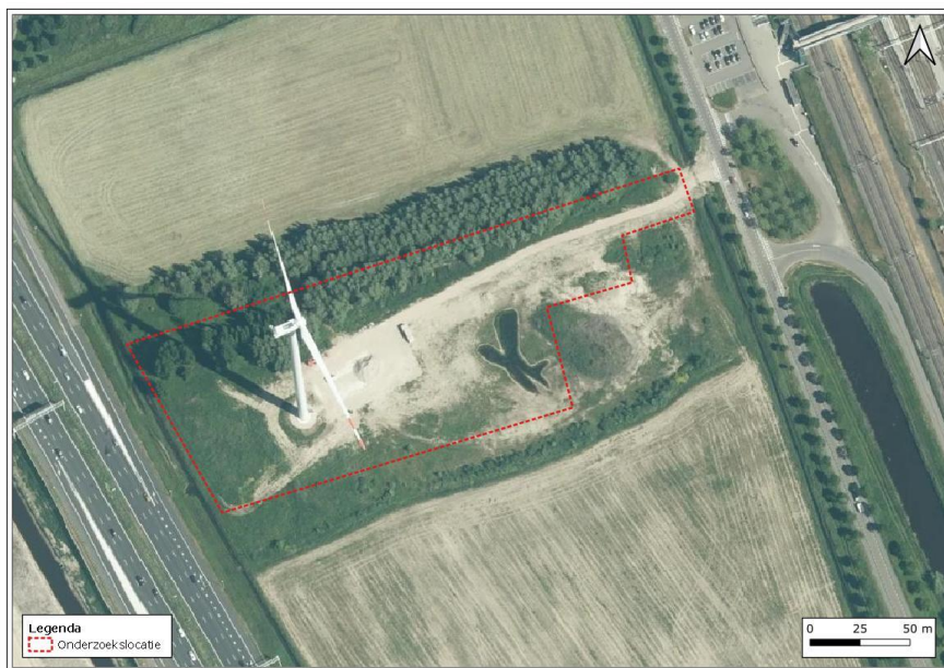
Figuur 2.3 Detailluchtfoto onderzoekslocatie en directe omgeving.
