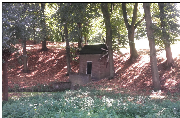
Afsluiter watergang bij één van de bastions
