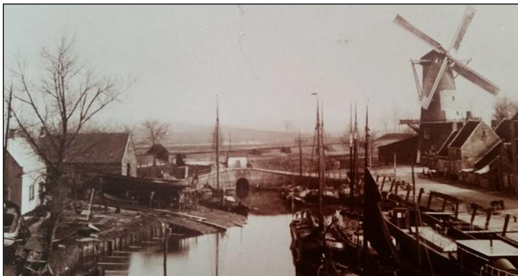
Voorheen was in de haven van Willemstad een scheepswerf gelegen; restanten zijn thans nog steeds zichtbaar.
