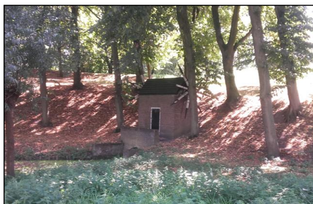
Afsluiter watergang bij één van de bastions
