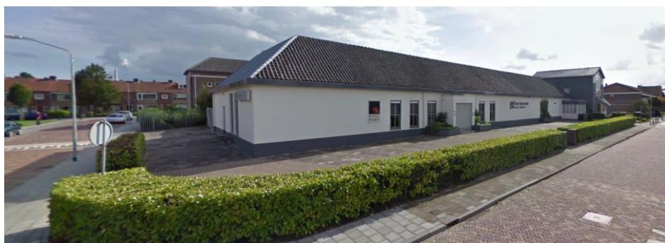
Figuur 2.1. Dansschool links en bijbehorende bedrijfswoning rechts (gezien vanaf de hoek Van Aerschotstraat – Willem III-straat)
