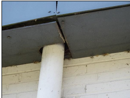
Figuur 12. Dakgoot van de dansschool waar ruimte aanwezig is bij de regenpijp.
