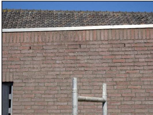
Figuur 11. Stootvoegen aan de achterkant van de dansschool.
