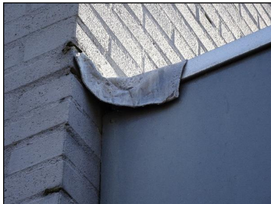
Figuur 14. Loodslab met beschikbare ruimte voor vleermuizen.
