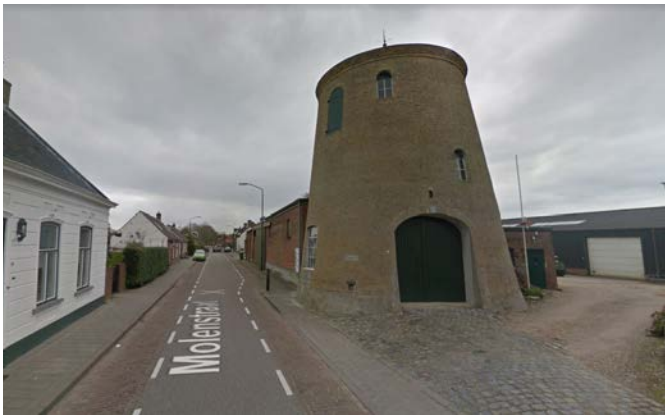
Figuur 2.2: Molenstraat (dijk), gezien richting het oosten. De locatie is gelegen achter de bestaande dijkwoningen.
