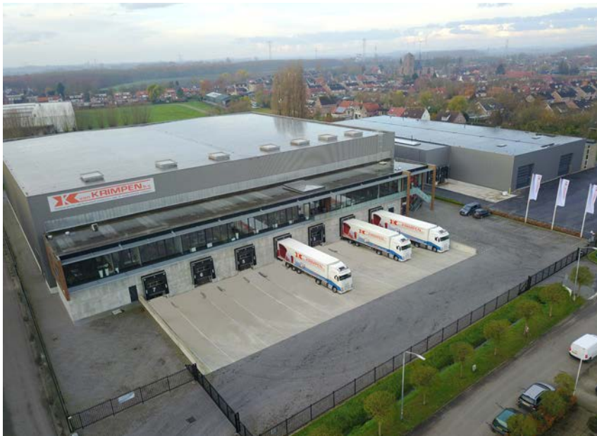
Figuur 3.2: Bestaande bedrijfspand aan de Molenstraat 42
