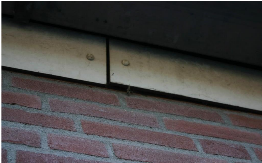
Figuur 4.4.4. De boeiboord kiert op meerdere plekken met de gevel, waardoor vleermuizen de achterliggende ruimte kunnen bereiken.
