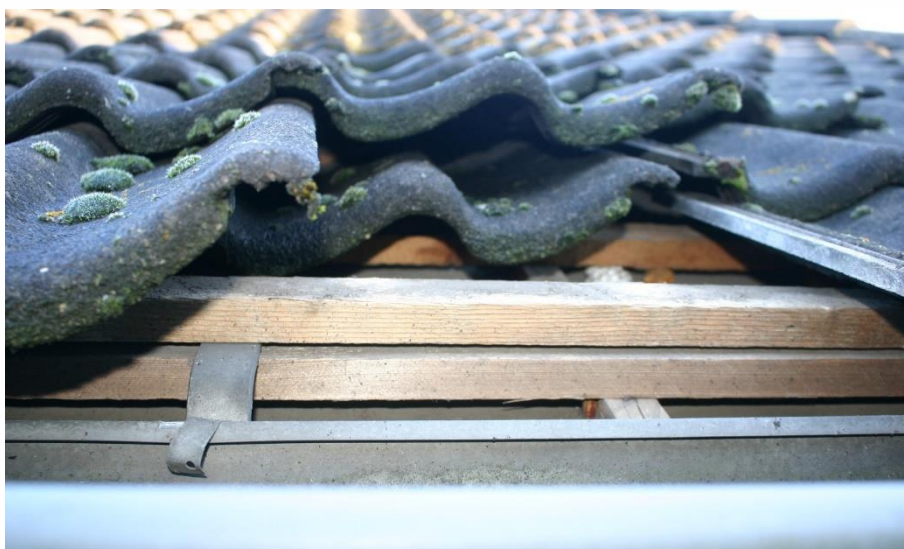
Figuur 4.4.5. Onder het pannen dak van de het oude gebouw en de loods (hier afgebeeld) is vogelschroot afwezig en voldoende ruimte voor huismusnesten.
