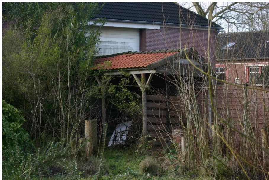
Figuur 4.4.1. Het westelijk gelegen schuurtje is enkelwandig en open aan twee zijdes.
