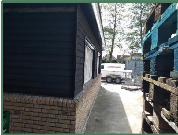
Overzicht aanbouw plangebied
