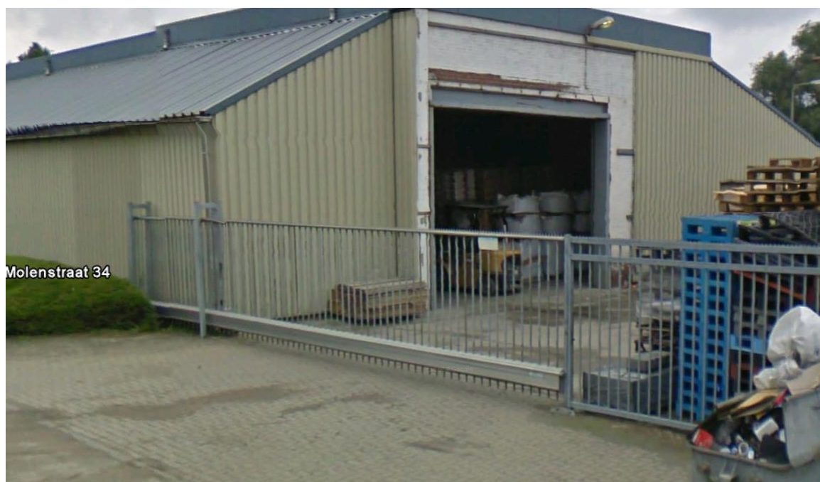
Foto B: Toegangspoort van gegalvaniseerd staal H= 2000 mm Br = 6,00 m
