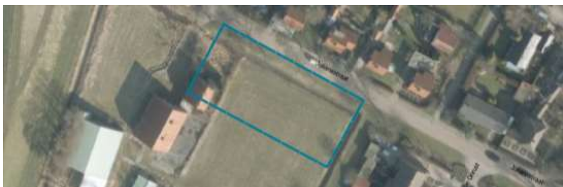
Afbeelding 2.3: Overzicht situatie 2011 met voormalige bebouwing Julianastraat 76 te Moerdijk (bron: 2)
