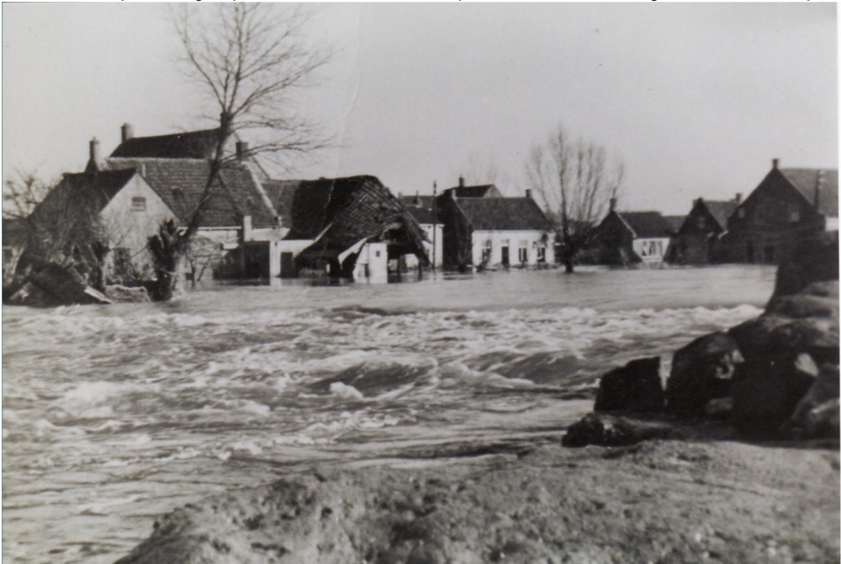
Foto van de dijkdoorbraak van de Buitendijk met op de achtergrond de werkplaats van firma Eland-Weda. Weergave van de achterkant van de woningen aan het Wilhelminaplein. Bron: Stichting Heemkunde Moerdijk.
