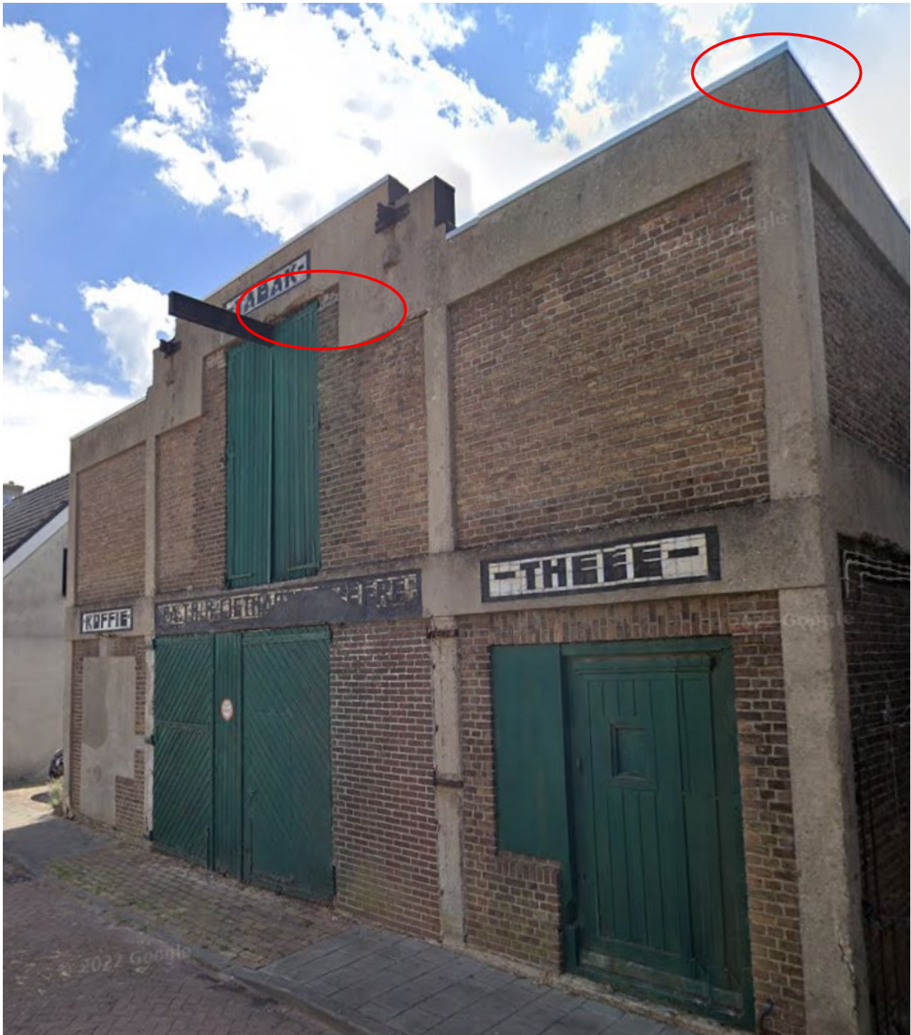
Afbeelding 6.1. Geschikte openingen voor vleermuizen (rood).
