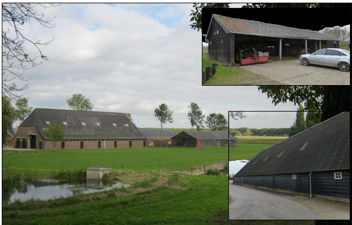
Figuur 2.1.2: Te slopen werktuigenberging en opslagloods
