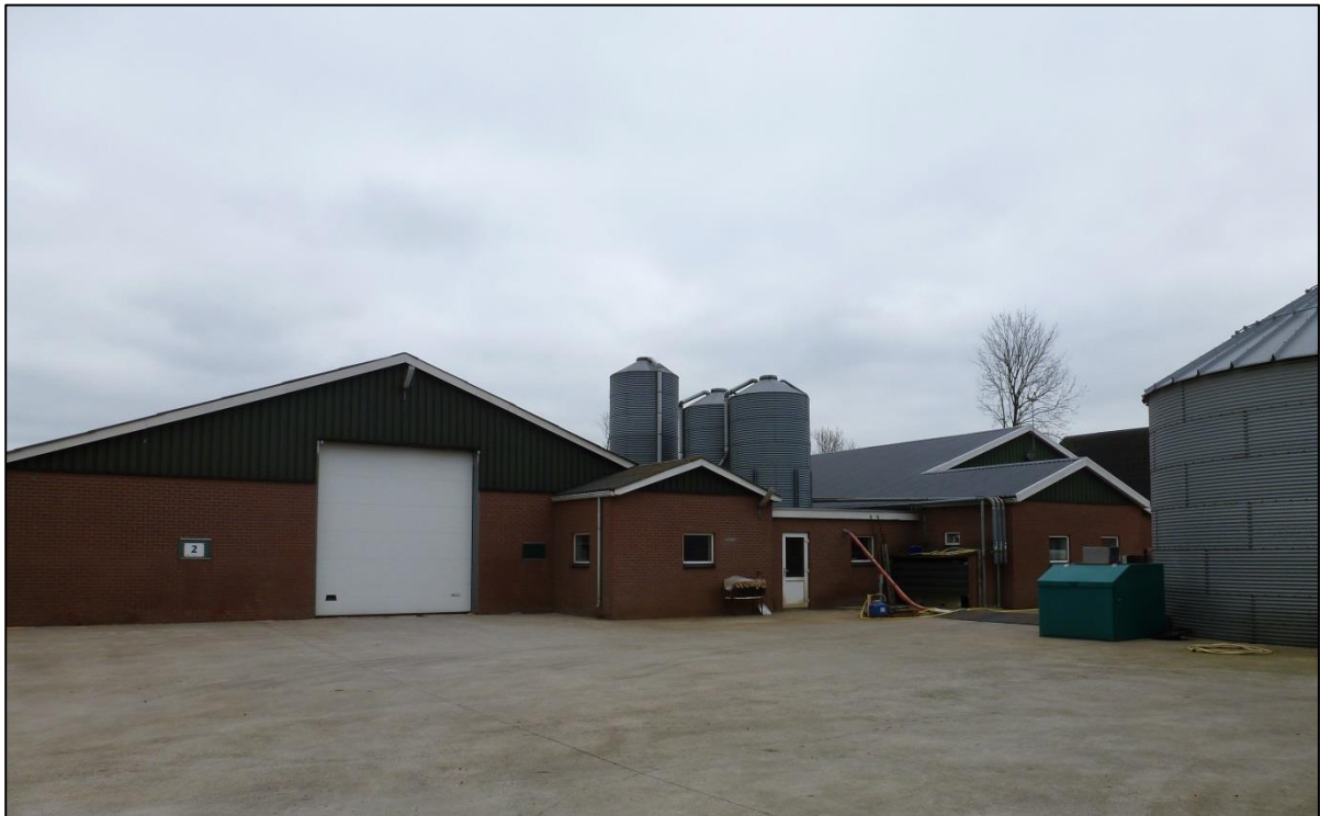
Figuur 2.1.4: Zicht op de bestaande pluimveestallen
