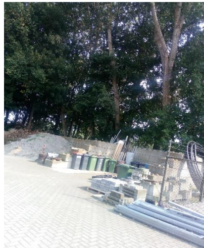
Foto 2 Opslag noordwestelijk deel van de locatie
