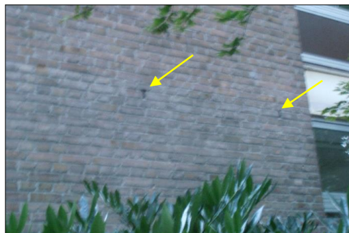
Figuur 14. Open stootvoegen met uitvliegers.
