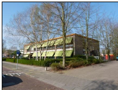
Figuur 4. De zuidzijde van de basisschool.
