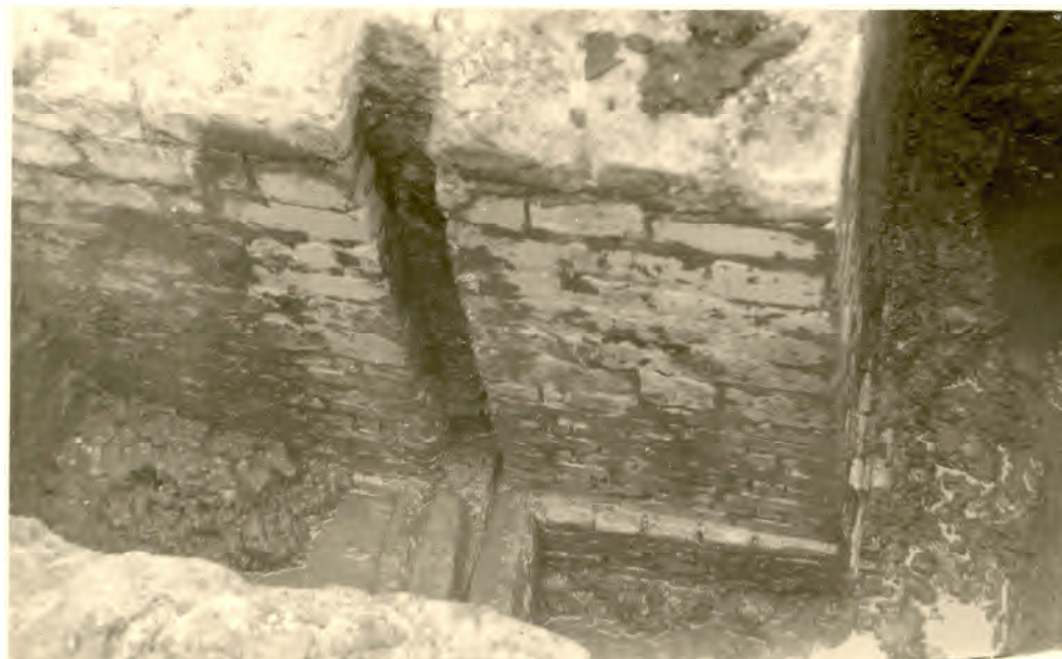
Afbeelding 12: één van de poeren met de gleuf voor de waterwerken (foto: heemkundekring Zevenbergen).
