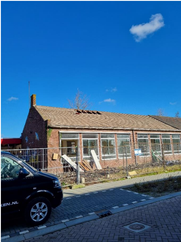
Figuur 8 Opening eerste deel dak van het hoofdgebouw
