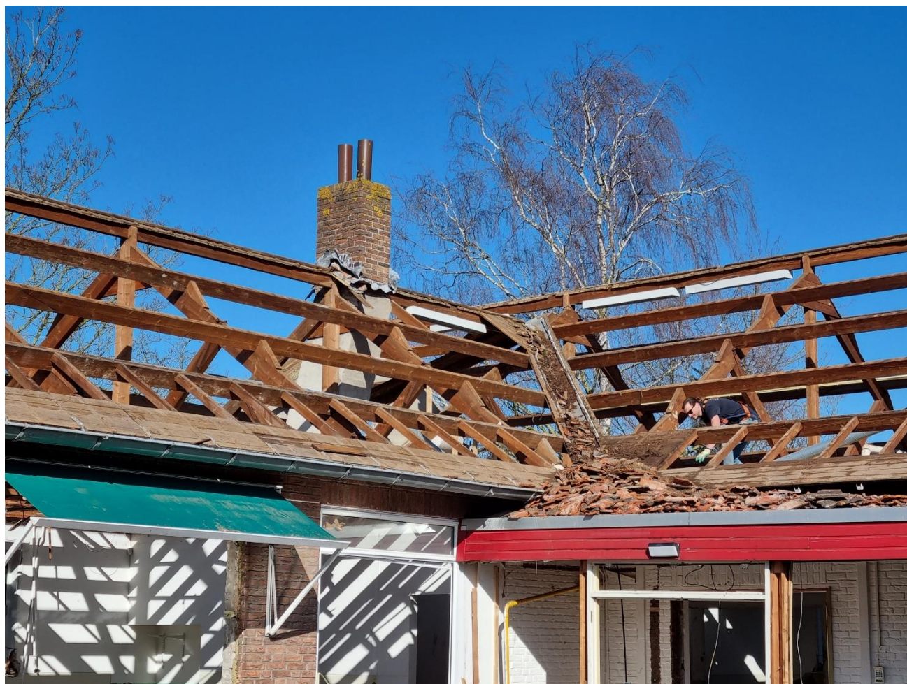
Figuur 6 Dak bijgebouw compleet geopend
