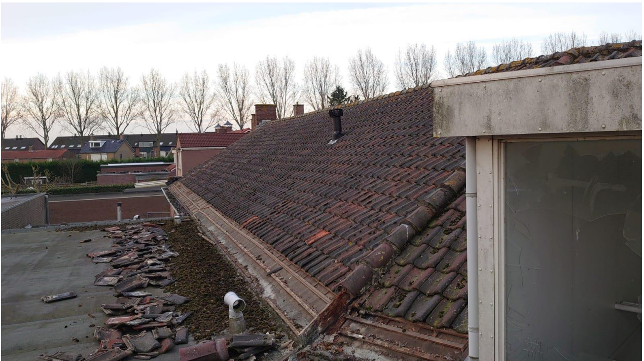
Figuur 9 Onderste rijen van dakpannen verwijderd van het resterende dak van het hoofdgebouw
