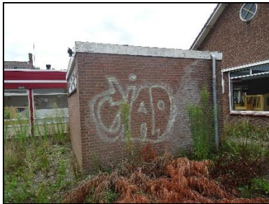
Figuur 15. Tweede opstal, een bijgebouw met plat dak en daklijst.
