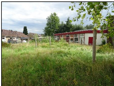
Figuur 6. Achteraanzicht van de bebouwing.
