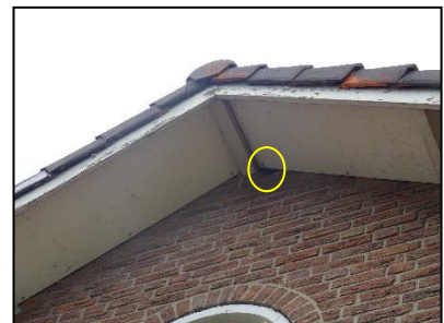
Figuur 11. Detailfoto van de opening tussen daklijst en buitenmuur, in de kopgevel aan de achterzijde van de bebouwing van de westelijke vleugel.
