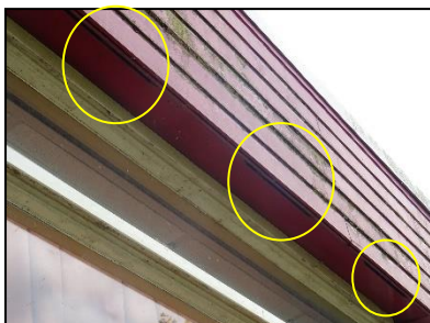
Figuur 12. Detailfoto van de openingen in de daklijst.
