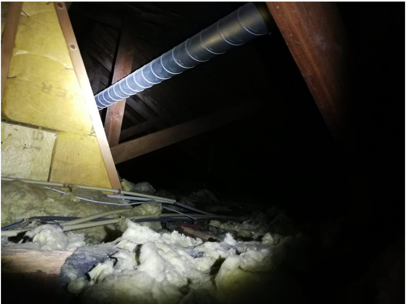
Figuur 2 Hoofdbalken op de zolders met isolatiemateriaal daar tussen
