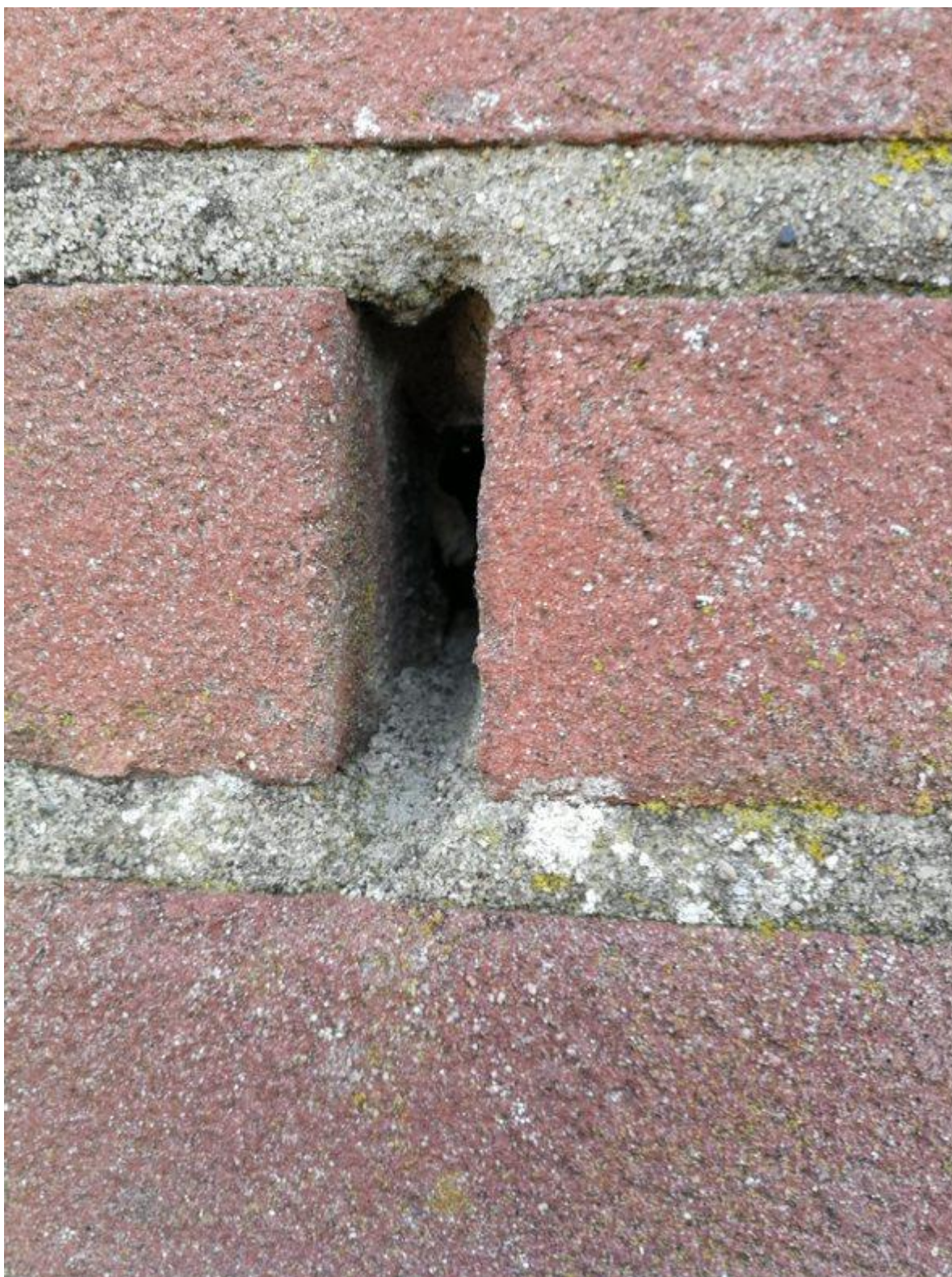
Figuur 5 Open stootvoeg, met daarachter duidelijk zichtbaar isolatiemateriaal
