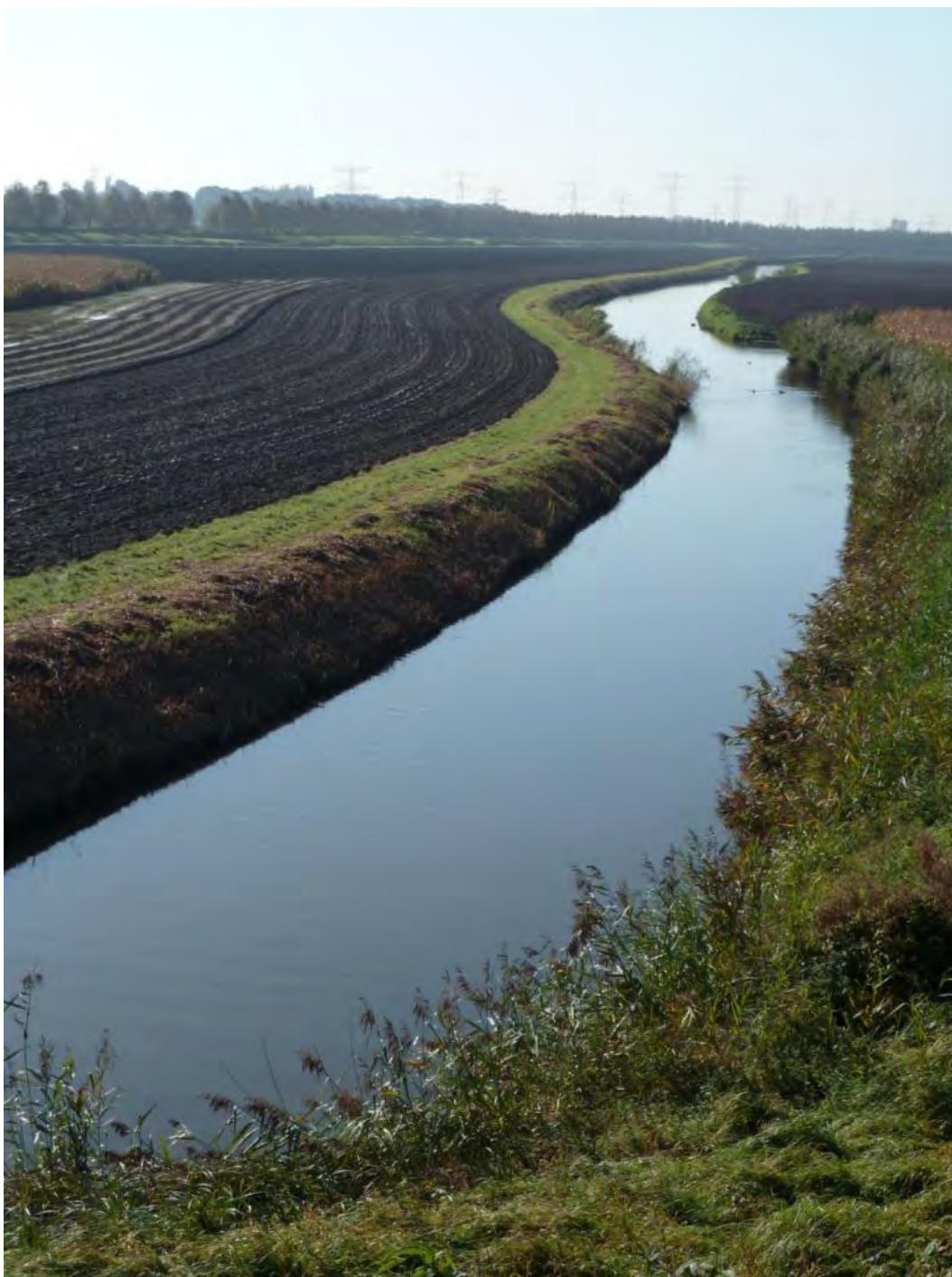
Figuur 1 Huidige situatie Keenehaven, meest zuidelijke deel - Deelgebied 1
