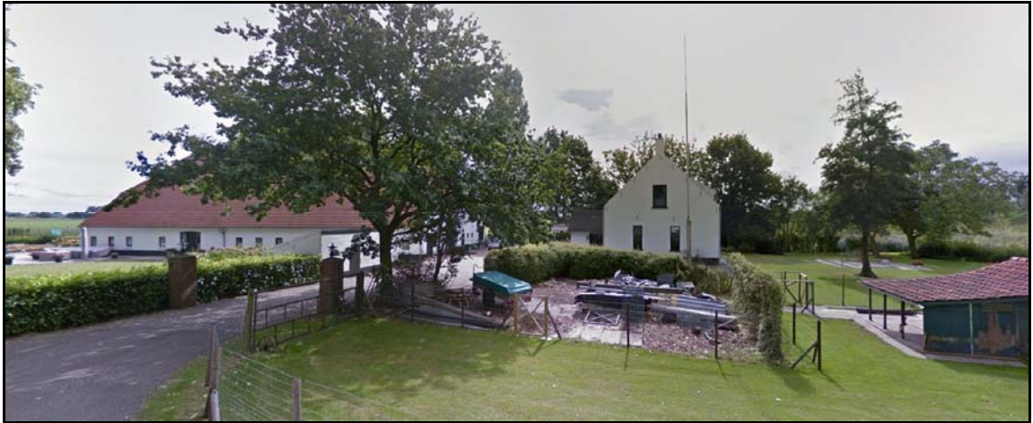
Afbeelding 3: Huidige bebouwing op het perceel Bredaschedijk 4.
