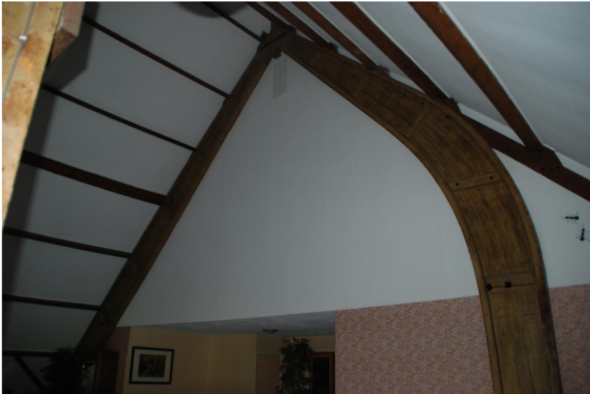
Afbeelding 15: Een gelamineerd spant ter plaatste van de vide.
