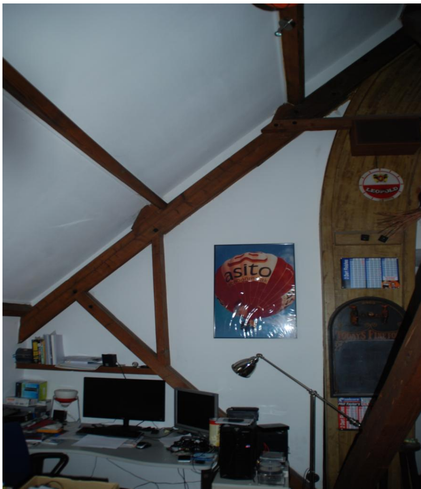
Afbeelding 16: Het halve spant in de zijbeuk.
