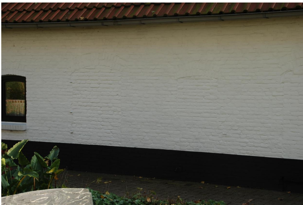
Afbeelding 11: Een detail van de zijgevel met een dichtgemetselde deur en een raam.
