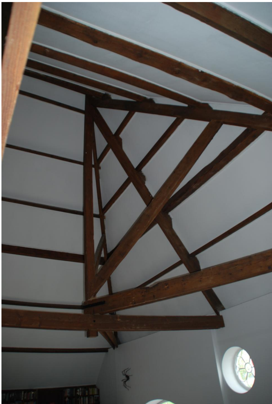
Afbeelding 17: De kapconstructie aan de achterzijde.
