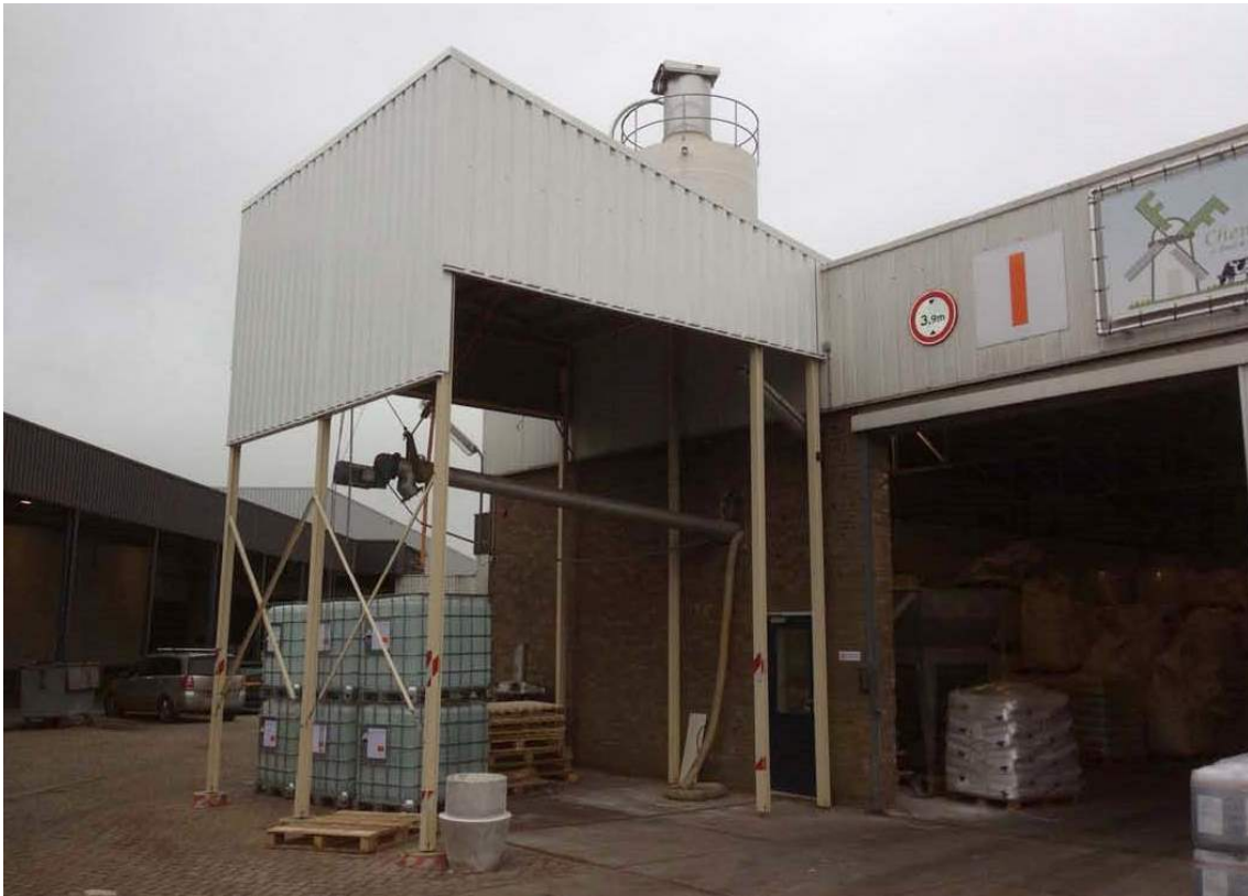
Figuur 1.2.. Gerealiseerde overkapping
