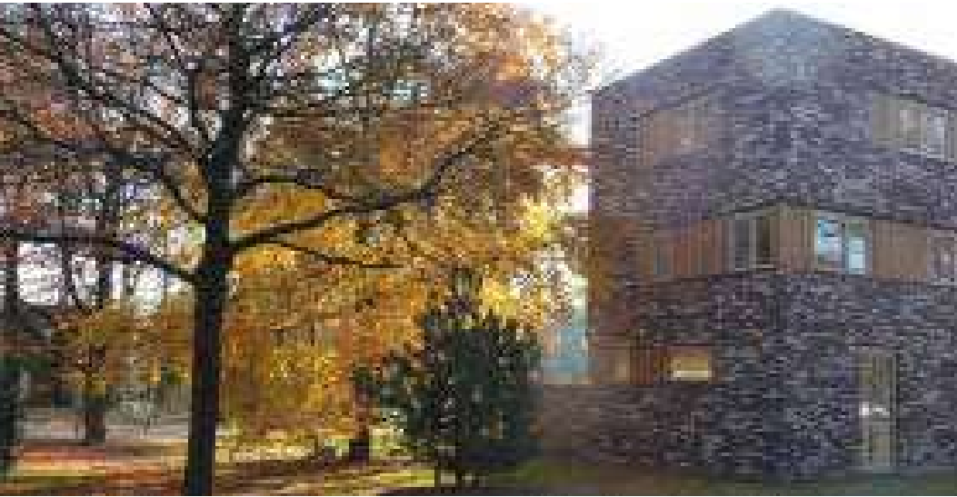
Belangrijke plekken krijgen een gebouwaccent
