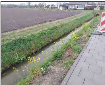
Figuur 3. Watergang gelegen aan noordostrand van de onderzoekslocatie
