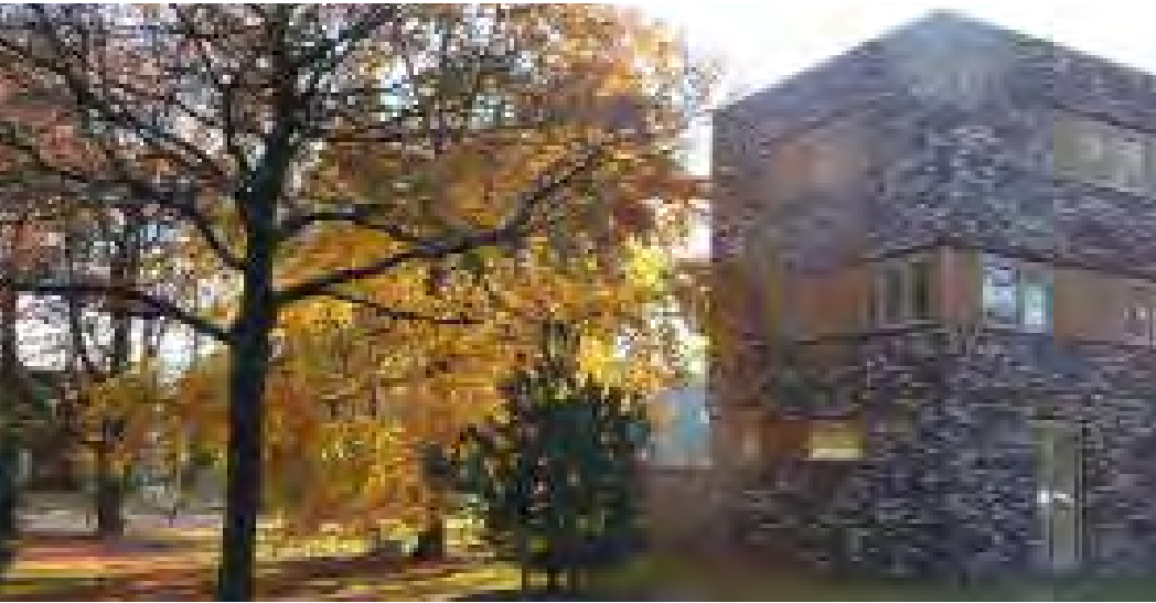
Belangrijke plekken krijgen een gebouwaccent
