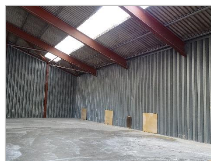
Foto 7: Pand 1 - graanopslag nu leeg.
