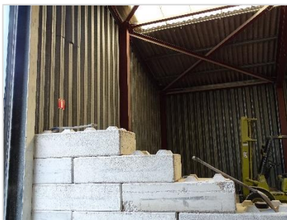
Foto 9: Pand 1 – graanopslag nu leeg.
