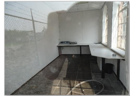
Foto 24: Pand 3 – huisje weegbrug interieur.
