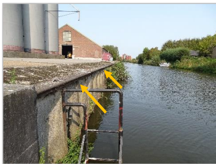
Foto 58: Kade aan Roode Vaart – regelmatig met gaten en openingen bij kade-rand.
