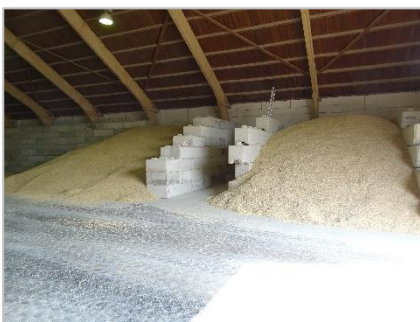
Foto 34: Pand 5 – nog in gebruik als graanopslag.
