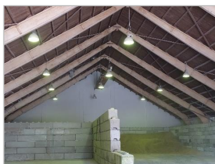
Foto 40: Pand 5 – nog in gebruik als graanopslag.
