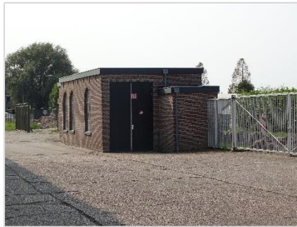
Foto 20: Pand 3 – huisje weegbrug.
