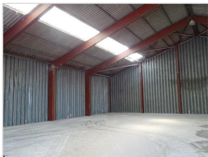
Foto 8: Pand 1 – graanopslag nu leeg.
