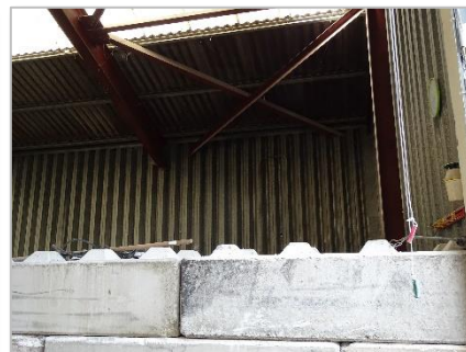
Foto 10: Pand 1 – graanopslag nu leeg.
