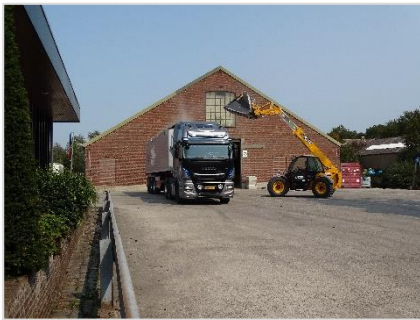
Foto 31: Pand 5 – nog in gebruik als graanopslag.
