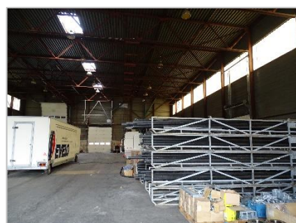
Foto 16: Pand 2 – interieur (opslag materialen).
