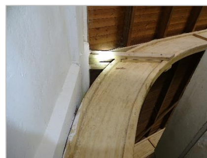
Foto 41: Pand 5 – binnenzijde aansluiting dak/gevel.
