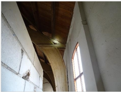
Foto 43: Pand 5 – binnenzijde aansluiting dak/gevel.
