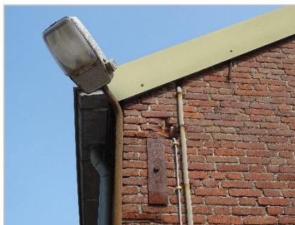
Foto 38: Pand 5 – kieren en openingen bij dakrand zuidzijde.
