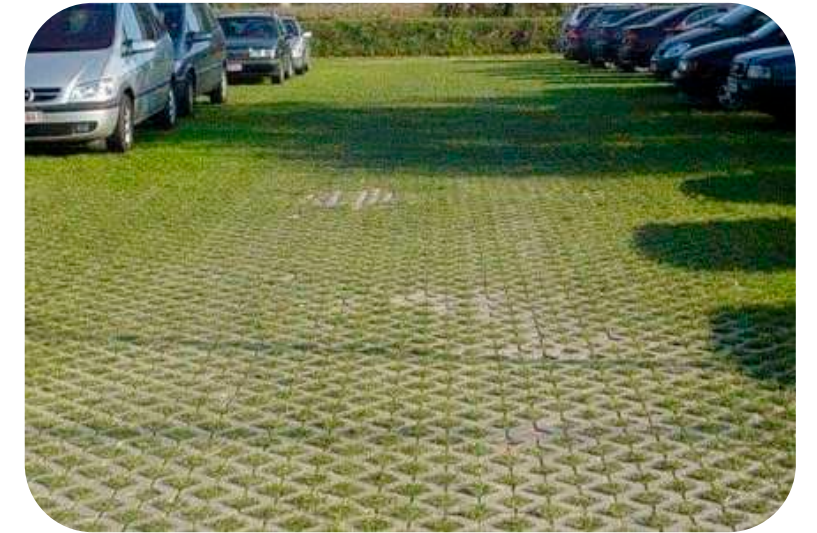
Grasbeton parkeren zonder markering
