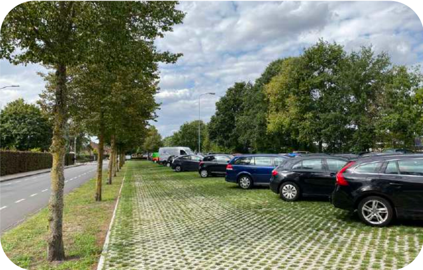
Parkeren op grasbetontegels
