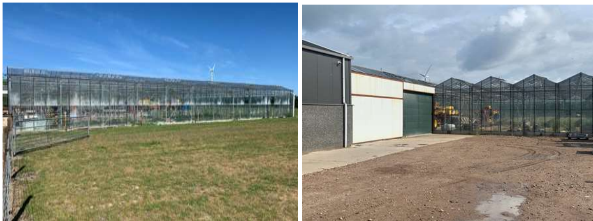
Figuur 3: te slopen kassen
