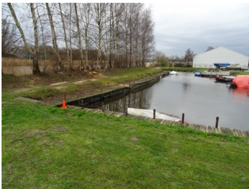
EVZ langs het haventje. Op de achtergrond de opening van het haventje en het vervolg van de EVZ langs de bebouwing Foto: K. van Veen | Ecoresult B.V.
