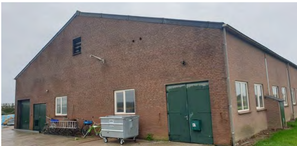
Kopgevel aan zijde woning, deel zijgevel wegzijde
