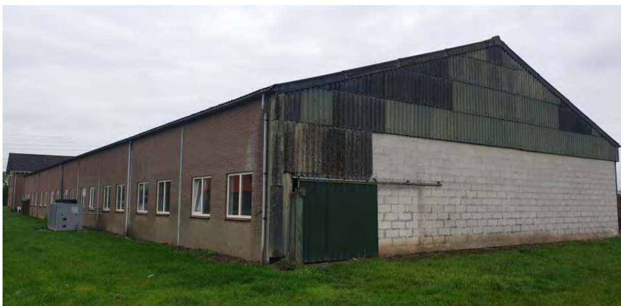
Zijgevel wegzijde en kopgevel noordwest zijde
