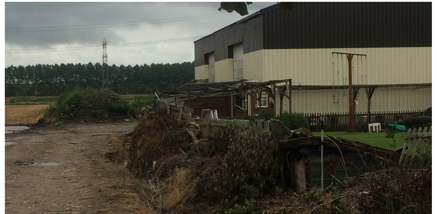
Huidige situatie, westzijde bedrijf.
