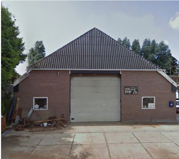
Abbeelding 9: zuidel.jk, naast Wetering-Oost 18 gelegen bedr.jfsgebouw
