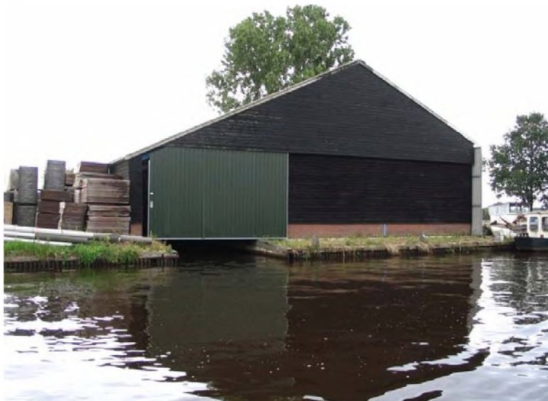
Atbeelding 7: bedrijfsgebouw met inpandige insteekhaven
