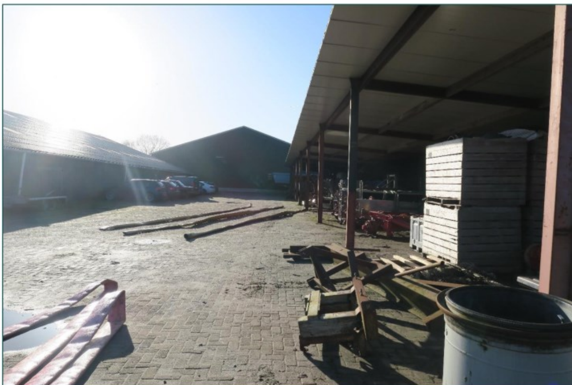
Figuur 3 De te slopen overkapping.
