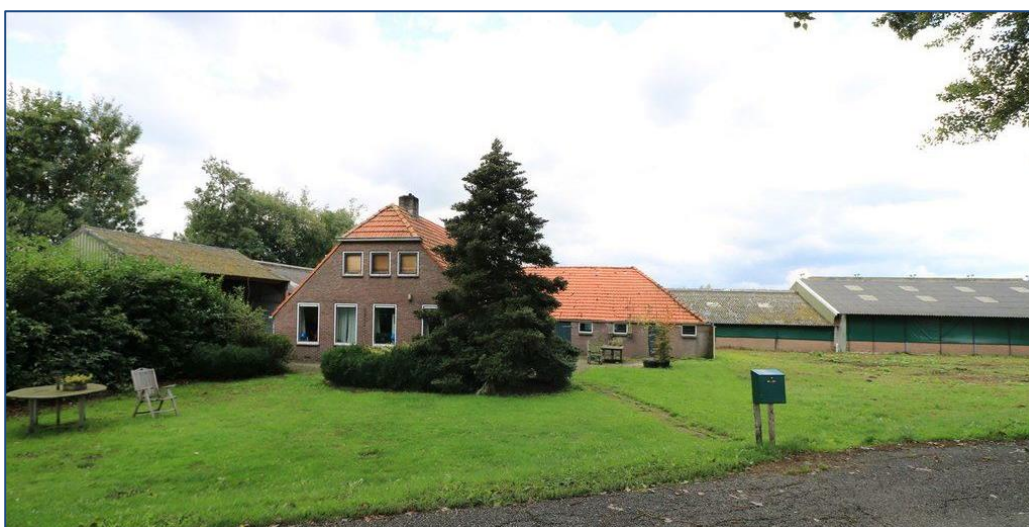
Fig. 2.4: De boerderij op het perceel Zomerdijk 12 te Wanneperveen. De bebouwing achter de boerderij is inmiddels gesloopt. Ook de boerderij is nagenoeg volledig gesloopt.
