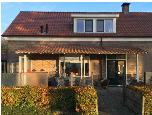
Figuur 8 Zuidzijde woning.
