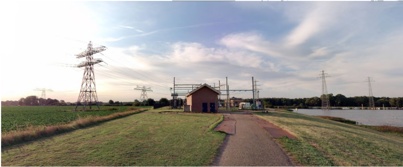
Figuur 3: Ontsluitingsweg / recreatief fietspad De Voorst nabij hoogspanningsstation
