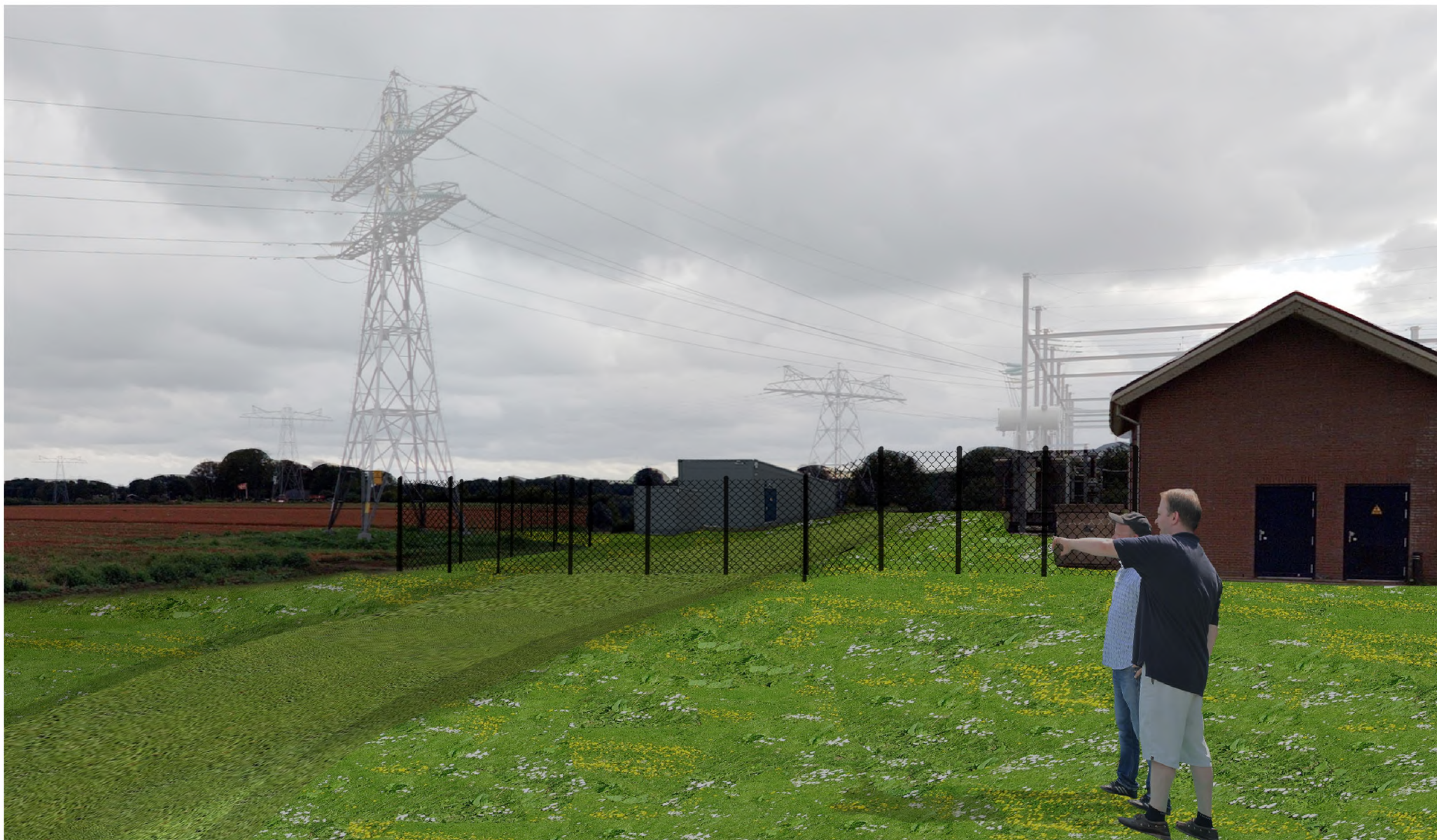
Figuur 26: Zicht in zuidelijke richting vanaf het fietspad De Voorst op het hoogspanningsstation en de uitbreidingslocatie
