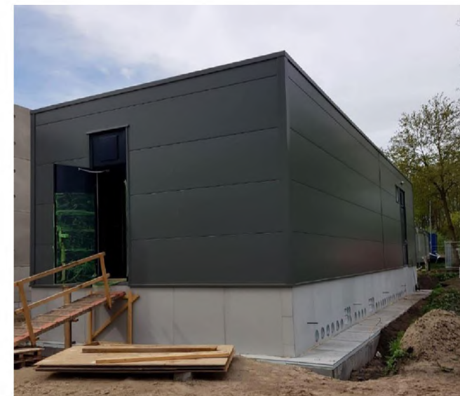
Figuur 20: Voorbeeld modulairgebouw met kabelingangstrook
