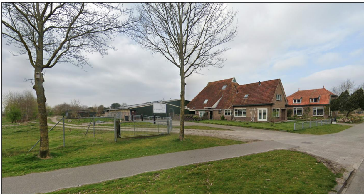
Afbeelding 2.3 Straatbeeld van de huidige situatie in het plangebied aan de Oldemarktseweg 103 (Bron: Google Street view)
