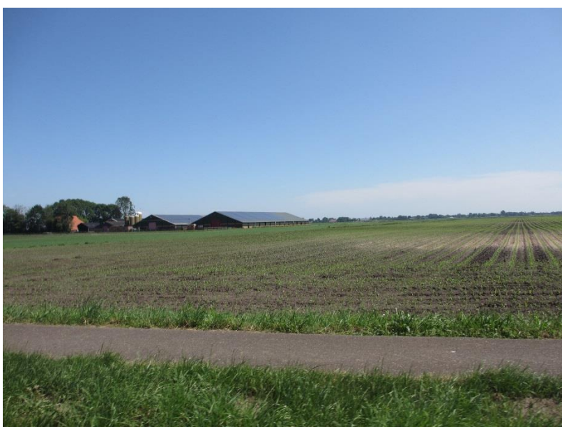
Figuur 2-6 Aanzicht op het bedrijf vanaf het fietspad aan de zuidzijde van het Steenwijkerdiep, goed te zijn met name de twee meest recente en hoogste pluimveestallen (Foto genomen op: 6 juni 2016)
