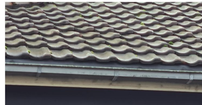
Figuur 11: Dak van het gebouw aan de Tukseweg 13
