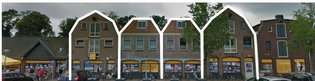
Figuur 21: Behoud en versterk het individuele karakter van de vier panden. De doorlopende gele kleur in de plint ondermijnt het individuele karakter.
