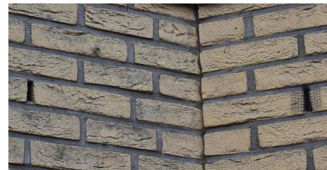
Figuur 13: Open stootvoegen met roostertjes in de gevel van Matthijs Kiersstraat 1
