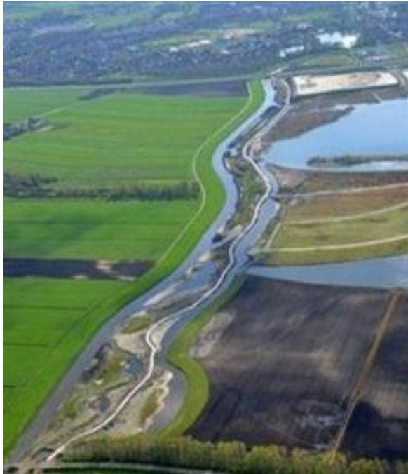
Figuur 2.3. Luchtfoto status verbindingzone langs de Steenwijker Aa omstreeks 2013 (bron: provincie Overijssel).
