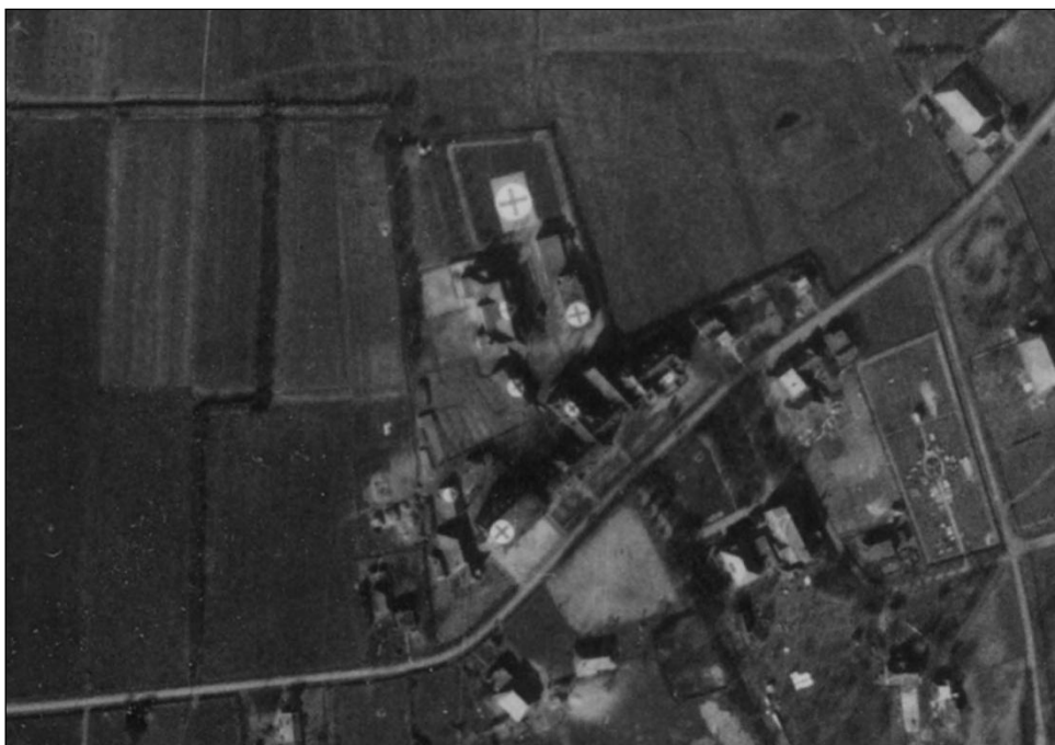
Afb.6.- Met behulp van rode kruizen werd kenbaar gemaakt dat ter plaatse gewonden werden verpleegd. Ook op de Van den Korput kazeme stonden dergelijke kruizen.
